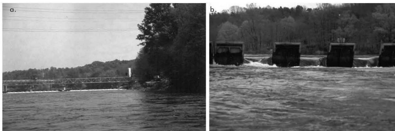
Figura 03– Diga della Miorina: veduta generale e particolare
