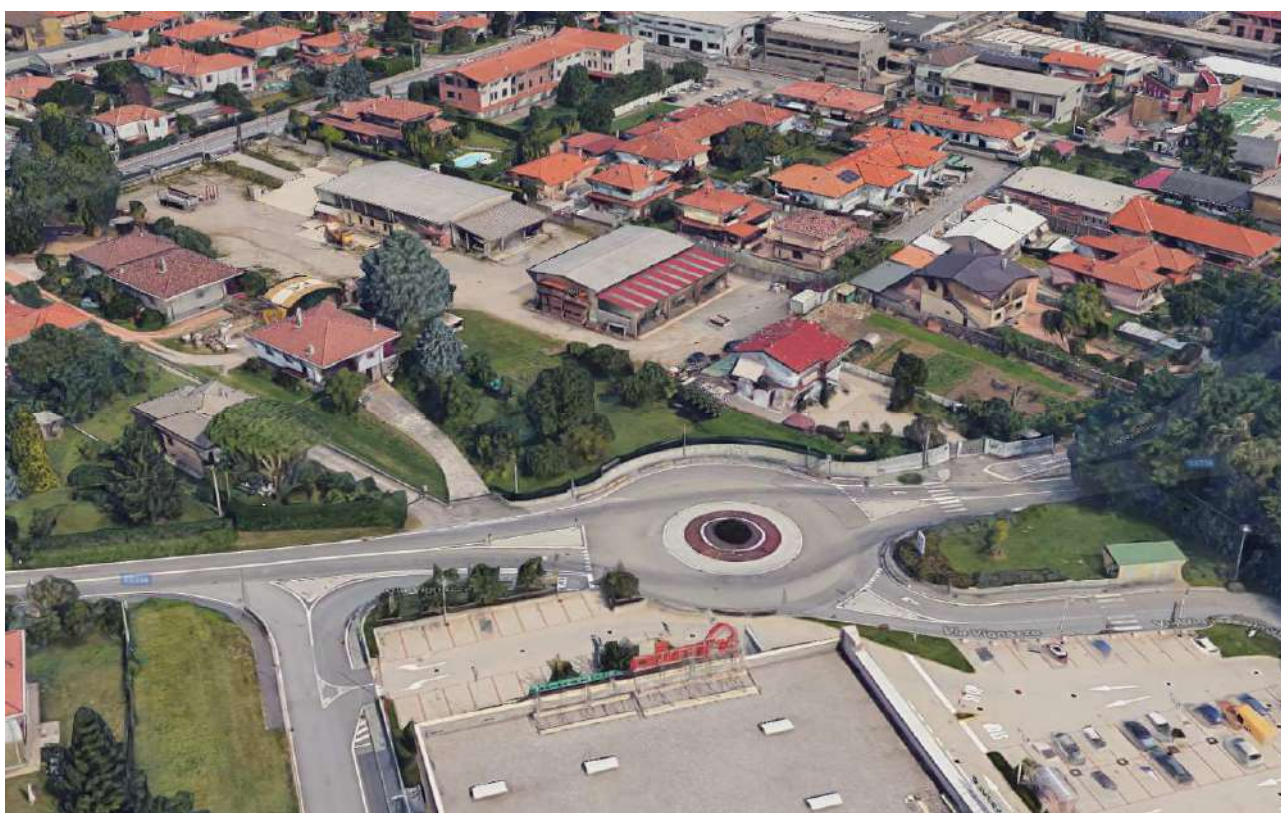
Stato di fatto – Vista Sud Ovest
