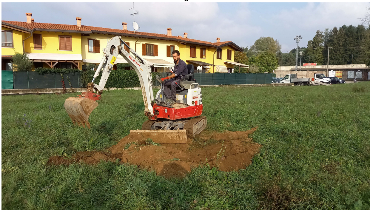
Foto 1 – panoramica dell'area con escavatore utilizzato
